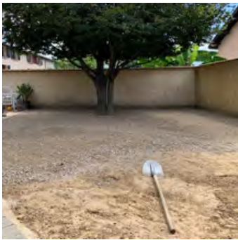
Nivelage du concassé
